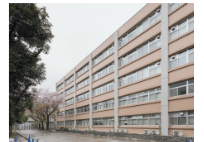
改修した経済学部研究棟
