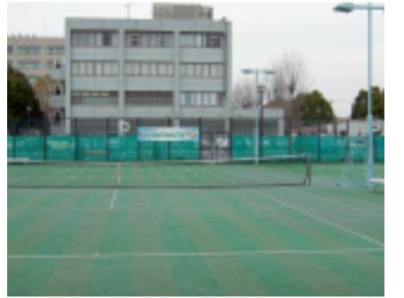
改修工事の完了したテニスコート
