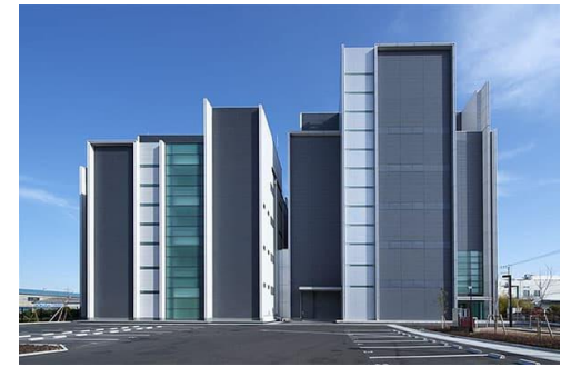
アイネット第2データセンター（横浜市）
